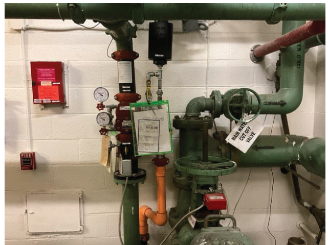
18 - FIRE SPRINKLER RISERS
